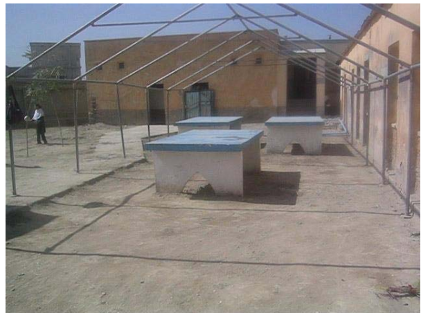
Les 3 tables de Ping Pong, en béton.
